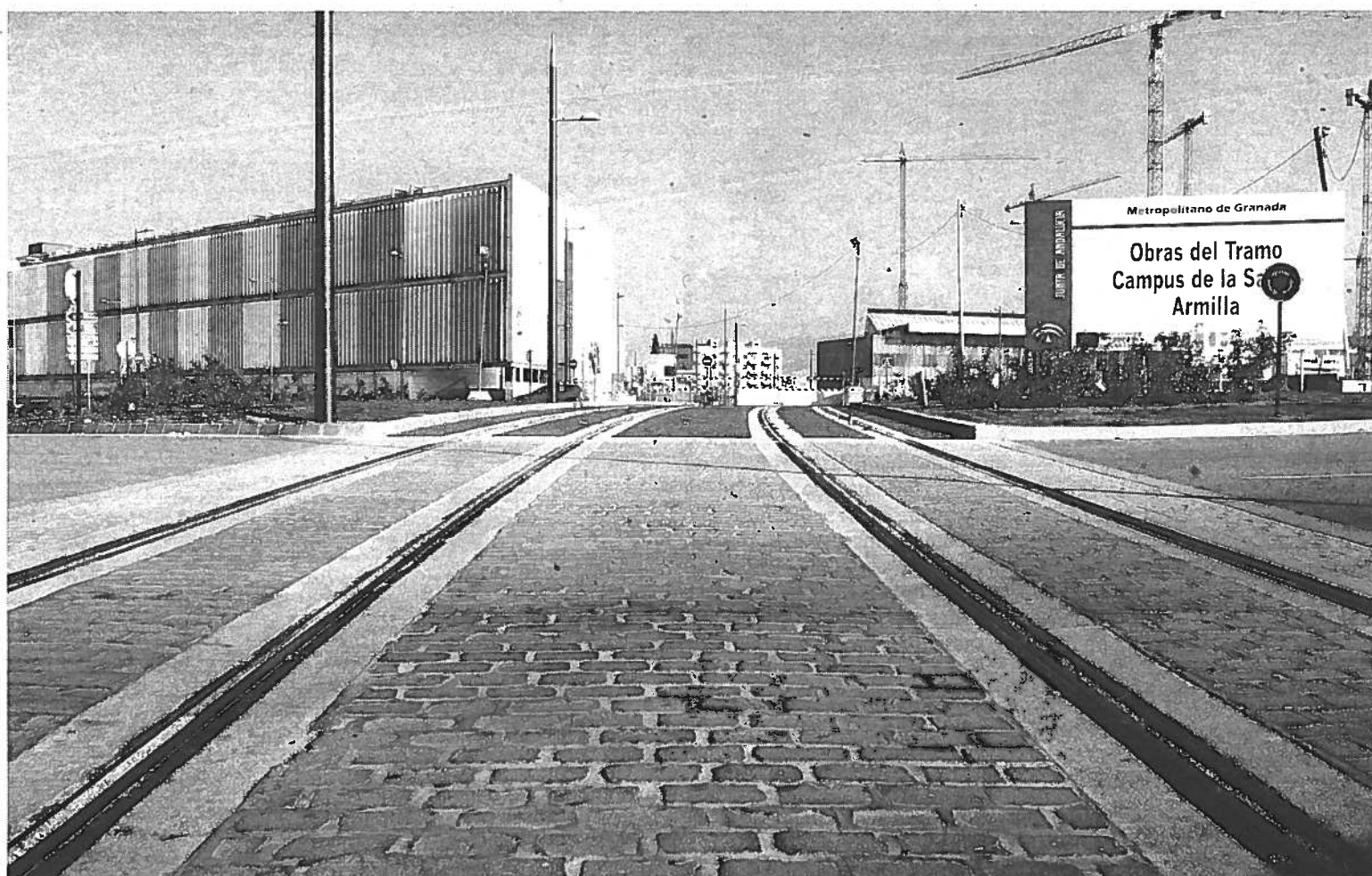
Vías revestidas con los neumáticos reutilizados y la resina polimérica en el tramo que va del Campus de la Salud hasta Armilla. :: G. MOLERO
